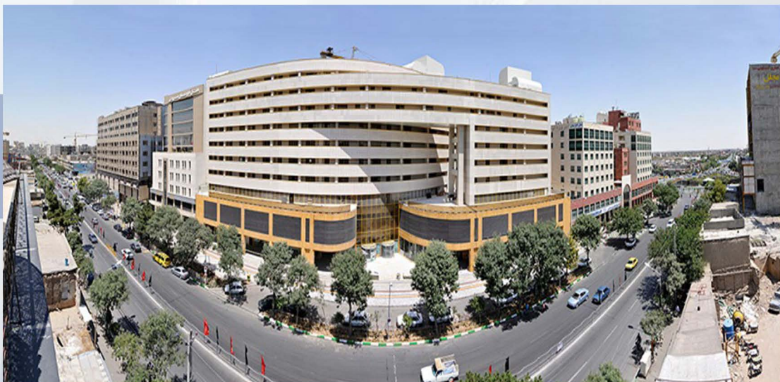
سرپرست کارگاه، مجری و پیمانکار مجتمع تجاری اقامتی ایمان اجرای کلیه تاسیسات مکانیکی به همراه ترسیم کلیه نقشه ها و شاپ های تاسیساتی و انجام امور دفتری خیابان نواب صفوی
