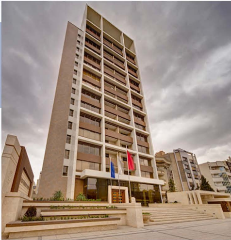
مشاور و راهبر تاسیسات برج مسکونی رز آرمیتاژ به همراه تعمیرات بوستر پمپ ها صارمی
