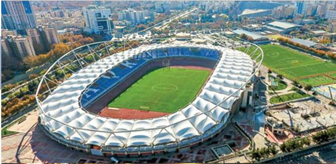
مجری، پیمانکار و بهره بردار استادیوم ورزشی مدرن امام رضا(ع) اجرای کلیه تاسیسات مکانیکی و الکتریکی به همراه راه اندازی و بهره برداری مجموعه ورزشی استان قدس رضوی
